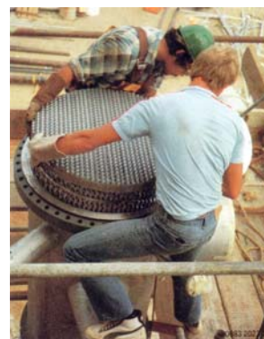
Foto 2. L'installazione di un elemento di riempimento strutturato in una colonna di piccole dimensioni
